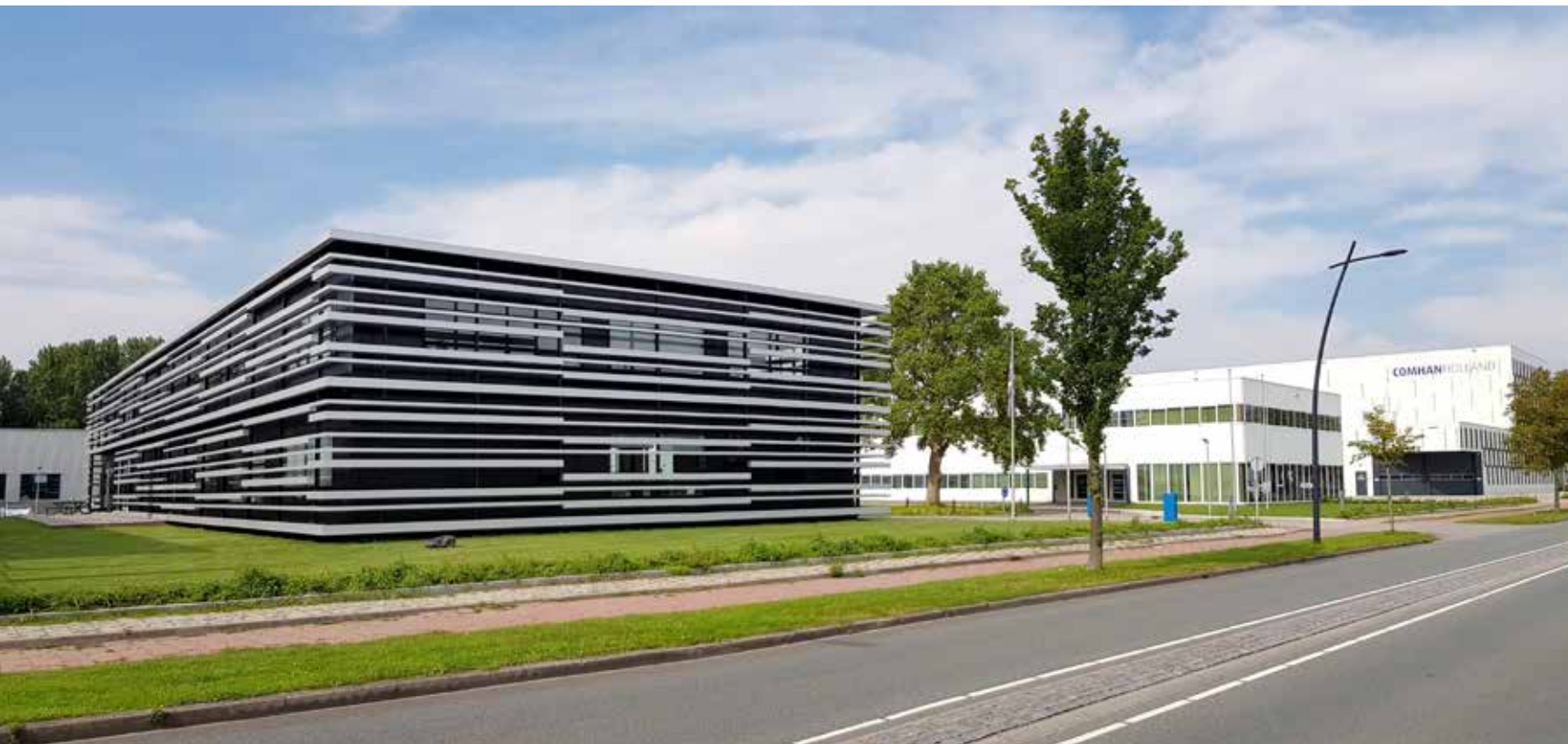
De duurzame uitbreiding van Comhan Holland maakt indruk met een bijzonder gevelontwerp, heel toepasselijk uitgevoerd met aluminium profielen uit 'eigen huis'.
