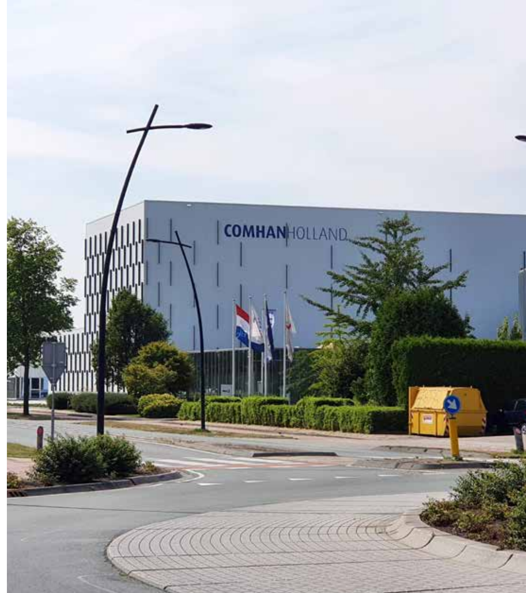
De verticale lamellen genereren een schaduwwerking op de gevel, zodat het magazijn minder massaal oogt in zijn omgeving.
