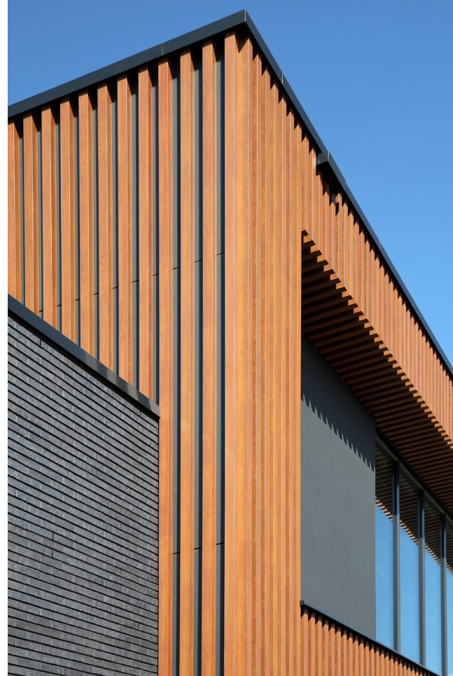
Dankzij de sublimatie naar houtstructuur hebben de aluminium profielen een natuurgetrouwe houtuitstraling gekregen.
