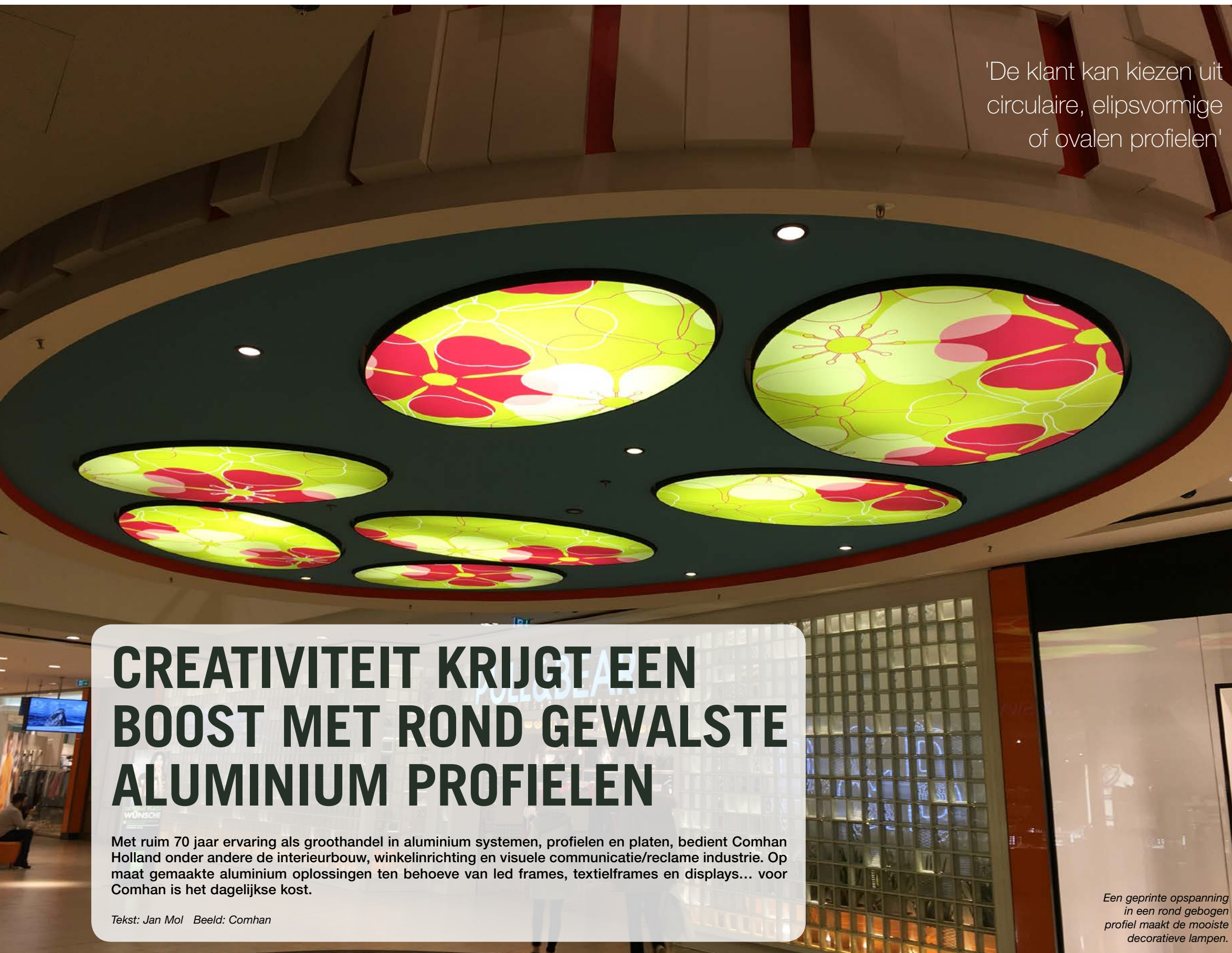
Sfeervolle verlichting door gebruik te maken van contra gepositioneerde, rond gewalste profielen.
